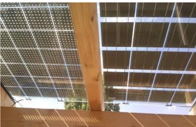
Abb.1: Semitransparente oder opake (lichtundurchlässige) PV-Zellen
