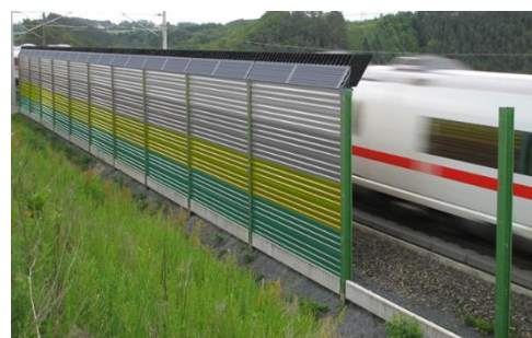
Abbildung 1: Beispiel einer Lärmschutzwand mit PV im Bahnverkehr, ©Calma-Tec
