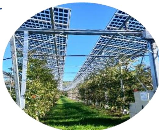
Abbildung 1: Hoch aufgeständerte Anlage mit durchgängigen Modulreihen-Versuchsstation Obst- und Weinbau Haidegg[5]
