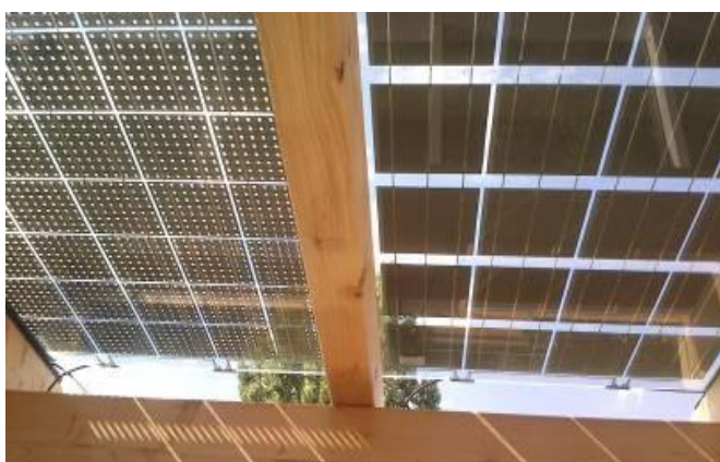
Abb.1: Semitransparente oder opake (lichtundurchlässige) PV-Zellen
