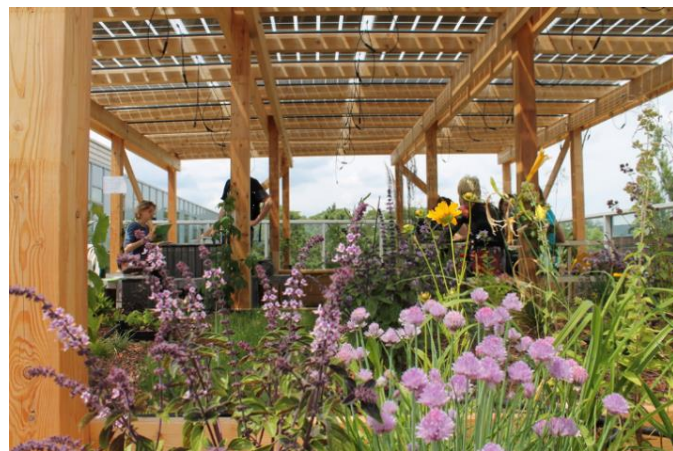
Abb. 2: Lebensraum mit bifazieller PV, Holz-Unterkonstruktion und Pflanzen, Umsetzung ATB Becker GmbH
